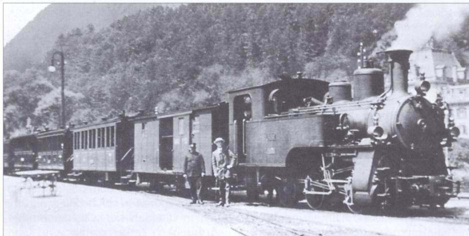
Dampfzug der zweiten Generation mit der HG 3/3 (um 1915, Foto: Archiv Jungfraubahnen)
